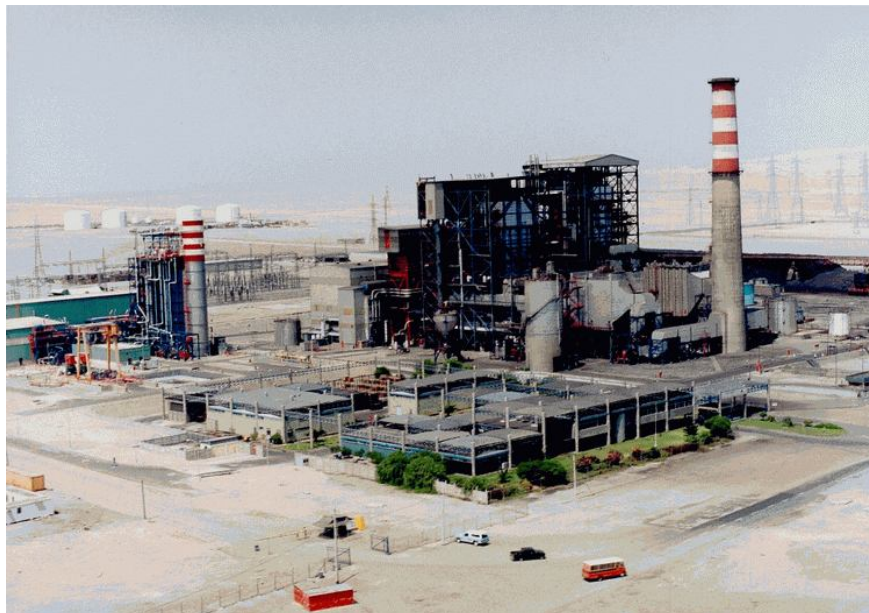
Central Termoeléctrica Mejillones
